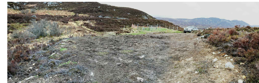
SITE PHOTO: A-A
