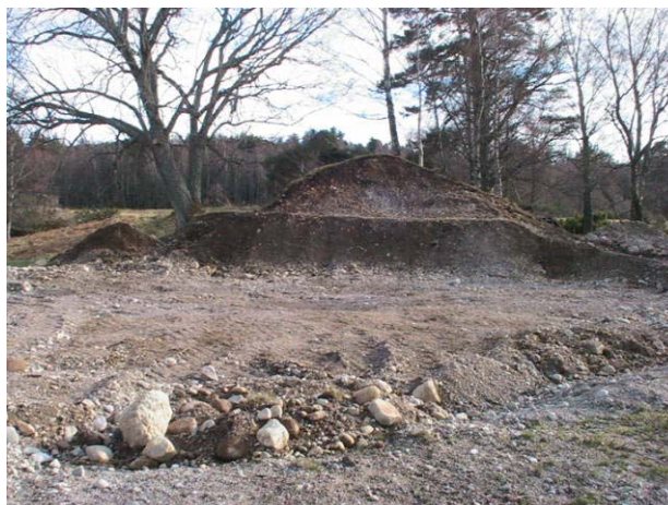
Fig. 8 : On-going site works
